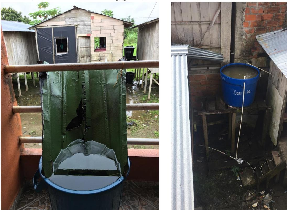
*Ilustración 18. Sistemas de recolección de aguas lluvias y mixto –de río y lluvias– identificados, 2017-2018.*
