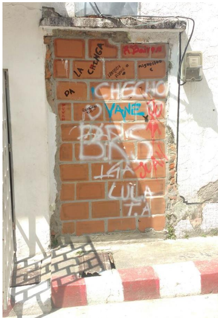
Figura 13.3. Mural actual de la esquina del sector – 2018
