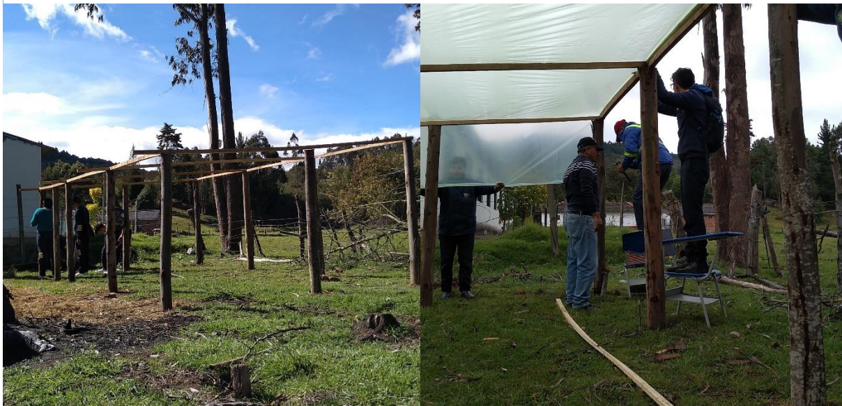
Ilustración 8. Construcción del invernadero.
