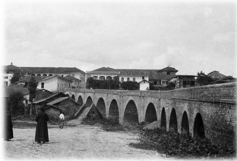
Fotografía 6. Puente de El Humilladero aproximadamente en el año 1930. Fuente: archivo de José María Arboleda C.
