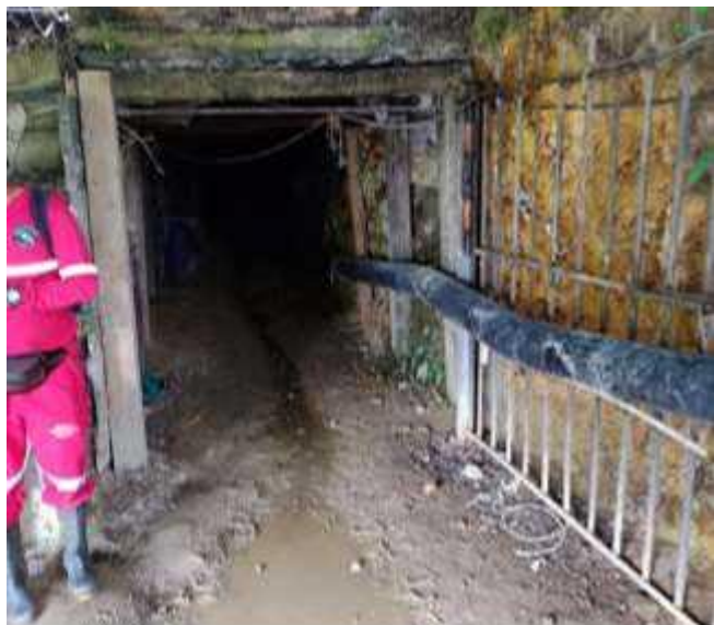
Figura 4 Bocamina La Centena de Occidente
