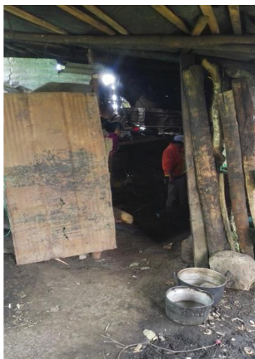
Imagen 21. Condiciones de la vivienda de Ángela
