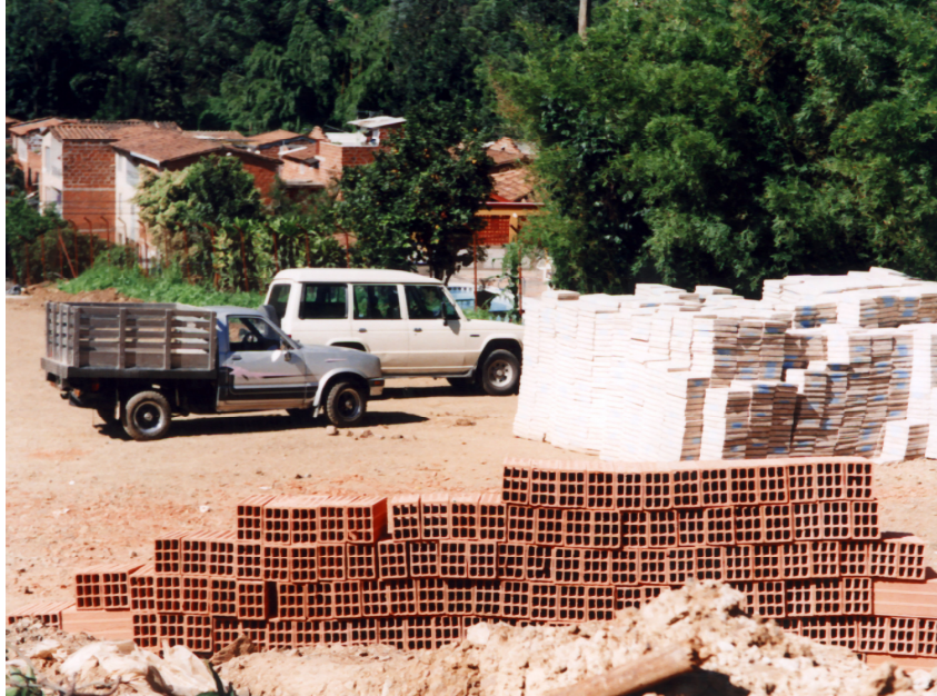
Archivo fotográfico Fundación Universitaria San Martín. Construcción Sede Sabaneta
