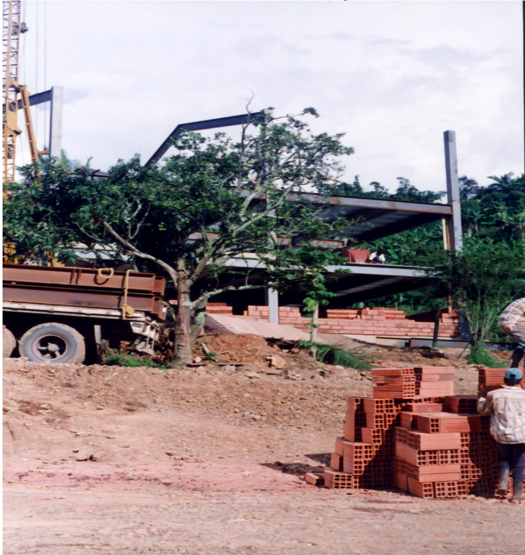
Archivo Fotográfico Fundación Universitaria San Martín. Construcción Sede Sabaneta
