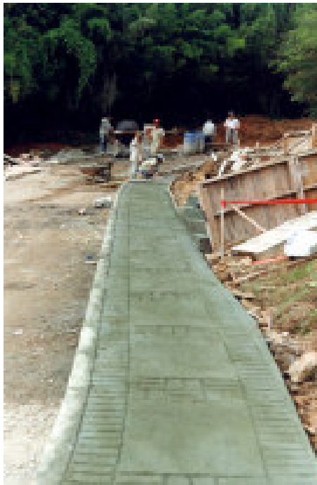
Archivo Fotográfico Fundación Universitaria San Martín. Construcción Sede Sabaneta
