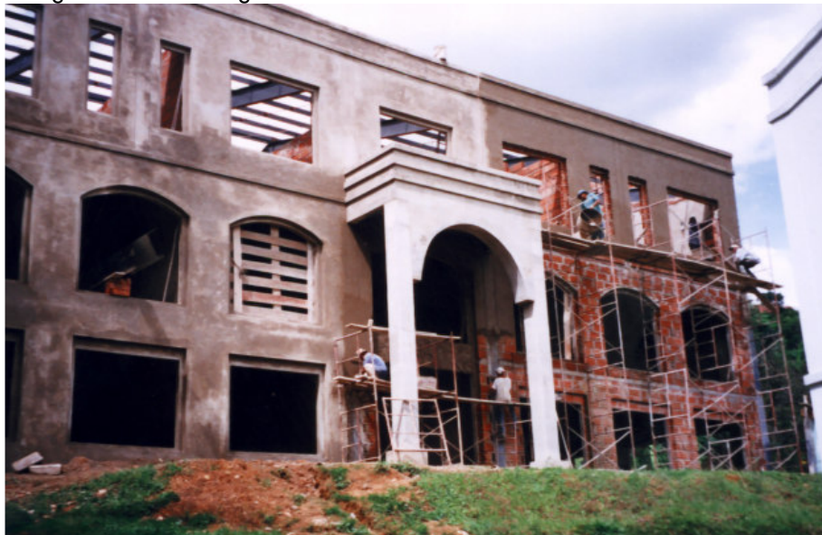
Archivo Fotográfico Fundación Universitaria San Martín. Construcción Sede Sabaneta
