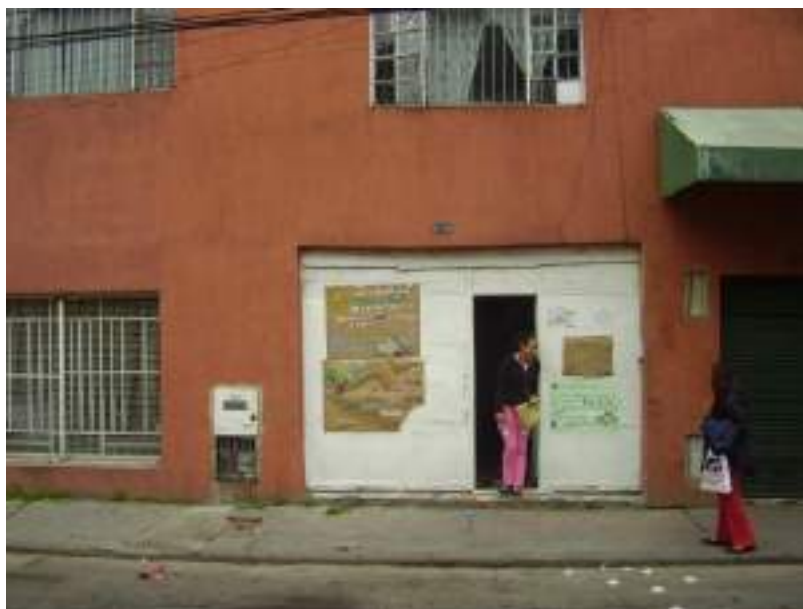
Fachada Centro de Desarrollo Integral el Camino
