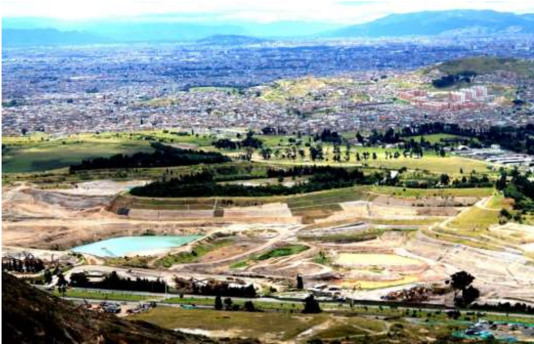
Fotografía 2: Parque Minero Industrial 2013. Canteras de Cemex y desviación del río Tunjuelo (autoría propia).
