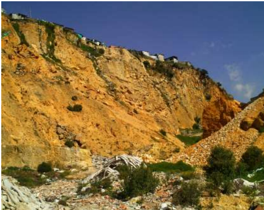
Fotografía 8: Asentamiento de barrios informales en zonas de riesgo y contaminación.
