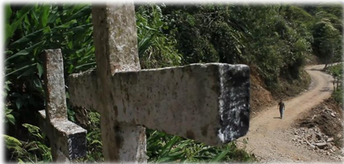
Fotografía 3. Calvario del sacerdote Ariel Arias García, vereda la Palma Fuente: Katherine Noreña
